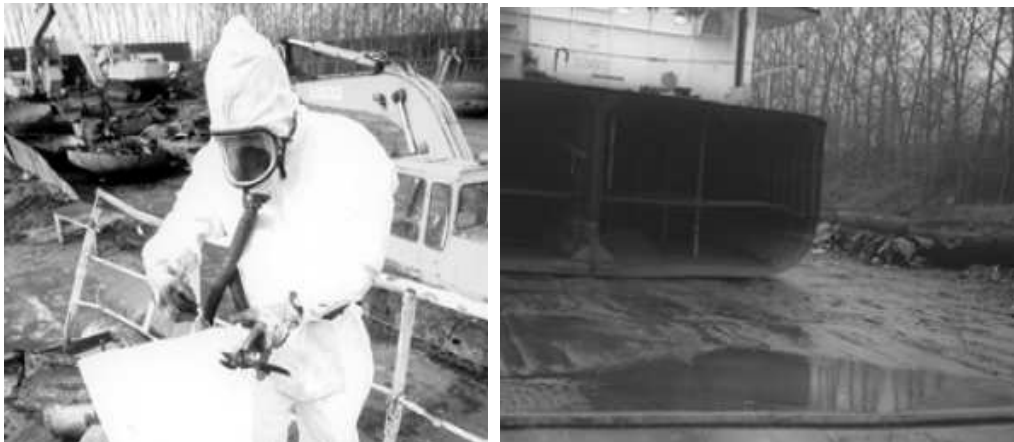
<그림2-18> 안전장구 착용 작업자의 석면제거작업(좌), 기름을 모으기 위한 선박해체장의 경사진 바닥(우)
