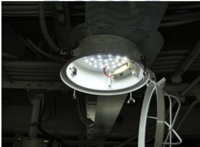
Fig.21 한바다호 엔진룸에 LED Dome Light 설치
