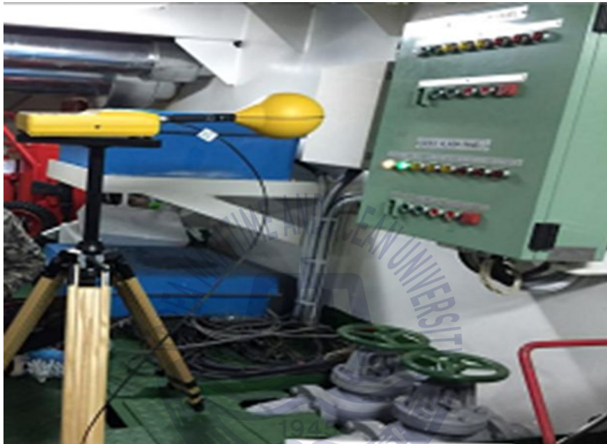
그림. 3-11 차도선 시험 설치(TR Room)
