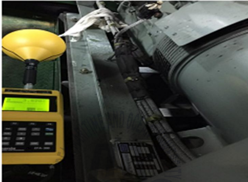
그림. 3-12 차도선 시험 설치(발전기)
