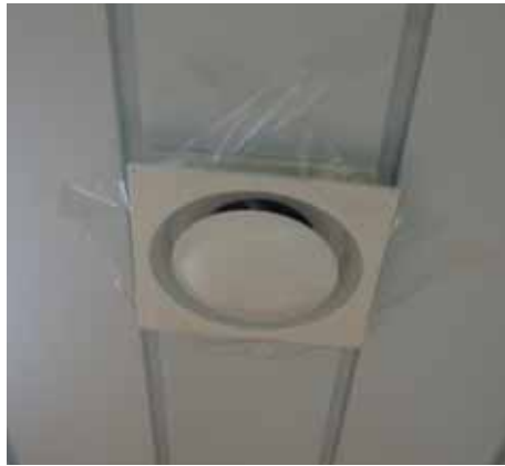
그림 3.2.1.5 급기구 교체한 모습
