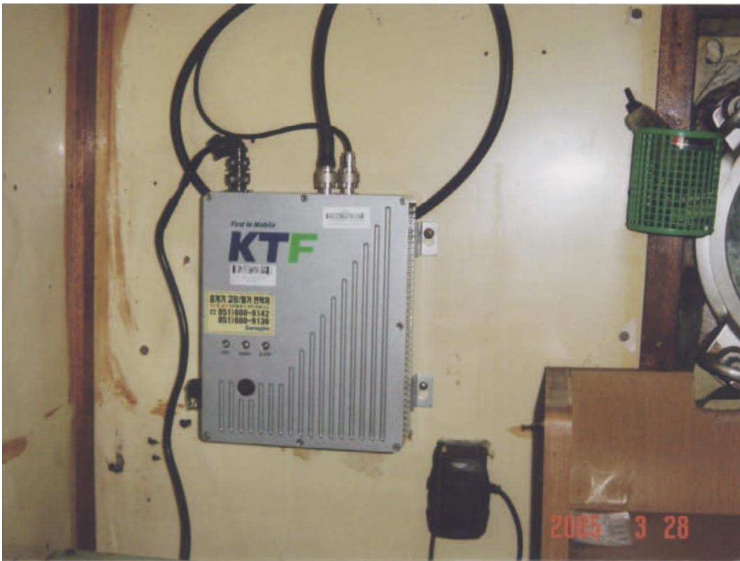
<그림-12> 해상용 중계기 설치 모습
