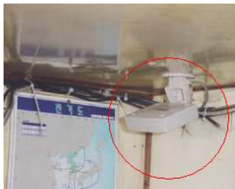
<그림-14> 패치 안테나 설치 모습
